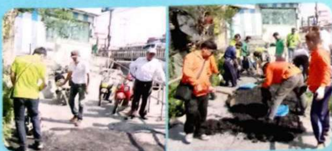
ซ่อมแซมผิวจราจรทางลอด
